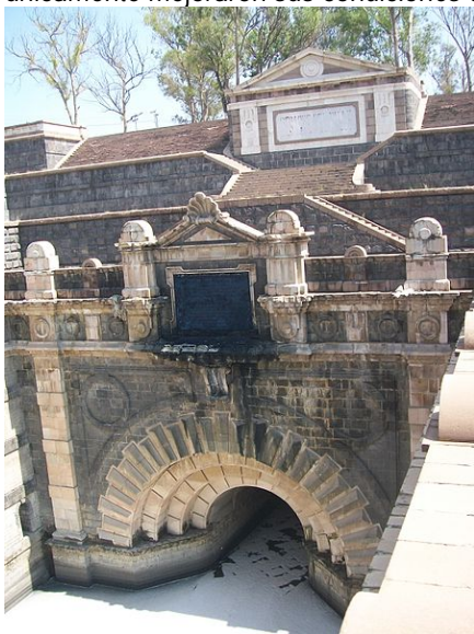
Desagüe de la Cd. de México, Zumpango [1900]
