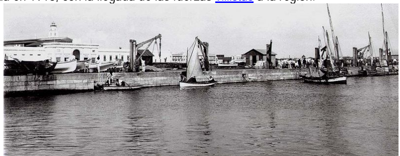
Obras en el puerto de Veracruz [1901]
