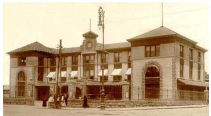
Estación Colonia de los Ferrocarriles
