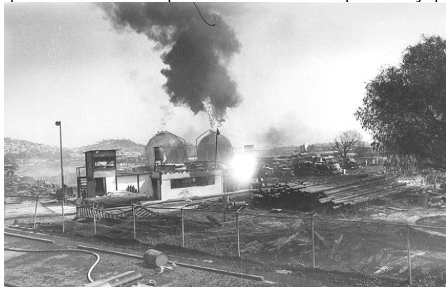
Explosión de gas en San Juan Ixhuatepec. Noviembre 19 de 1984 AGN, Archivo Fotográfico Hermanos Mayo
