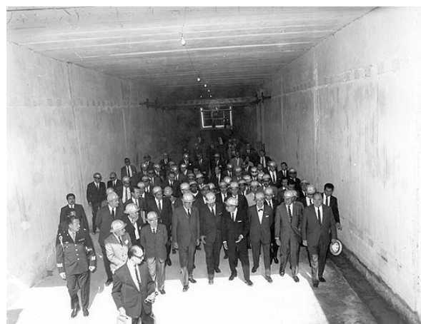
Gustavo Díaz Ordaz inspecciona las obras del Metro. Marzo 27 de 1968. AGN, Colección de la Presidencia de la República, Gustavo Díaz Ordaz
