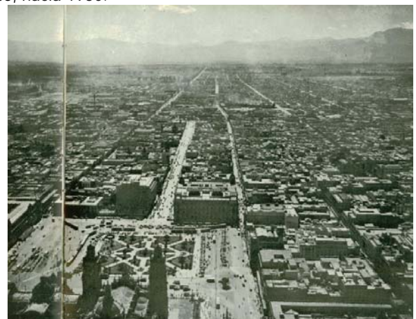
Ampliación de la Avenida 20 de Noviembre
