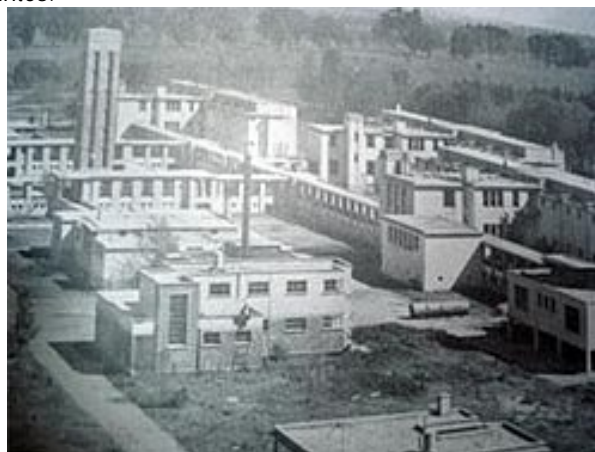
Hospital de Huipulco en construcción [1936]
