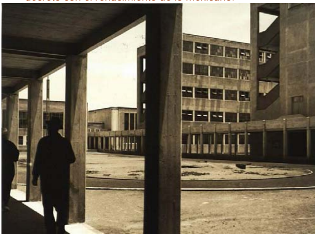
Centro Escolar Revolución en construcción [1934]
