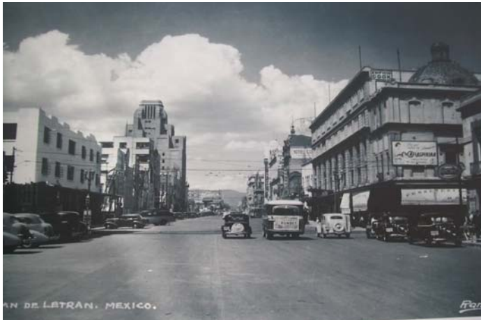
Ampliación de la Avenida San Juan de Letrán [ca.1935]
