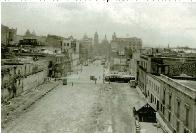
Ampliación de la Avenida 20 de Noviembre
