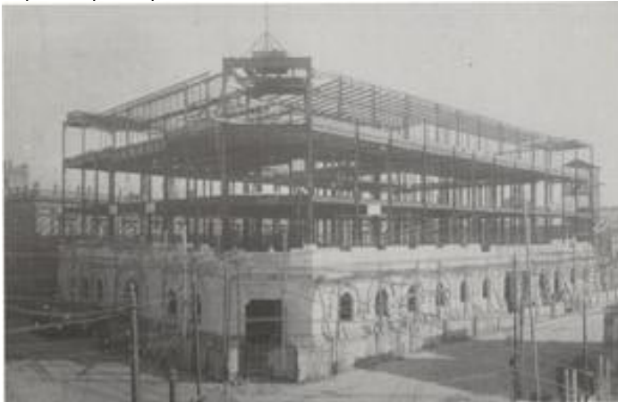
Palacio Postal en construcción
