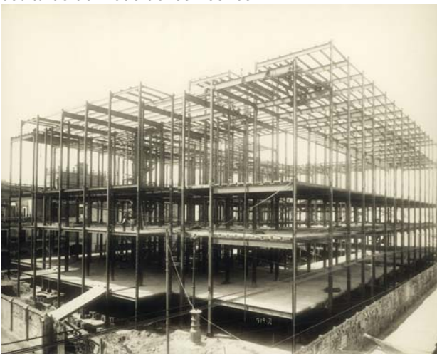
Construcción del Palacio de Comunicaciones [ca. 1910]
