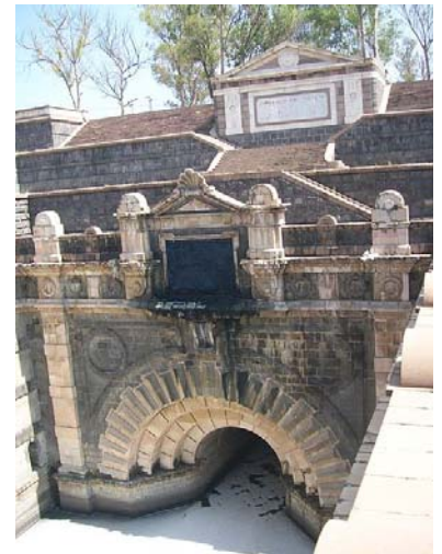
Desagüe del Gran Canal en Zumpango México
